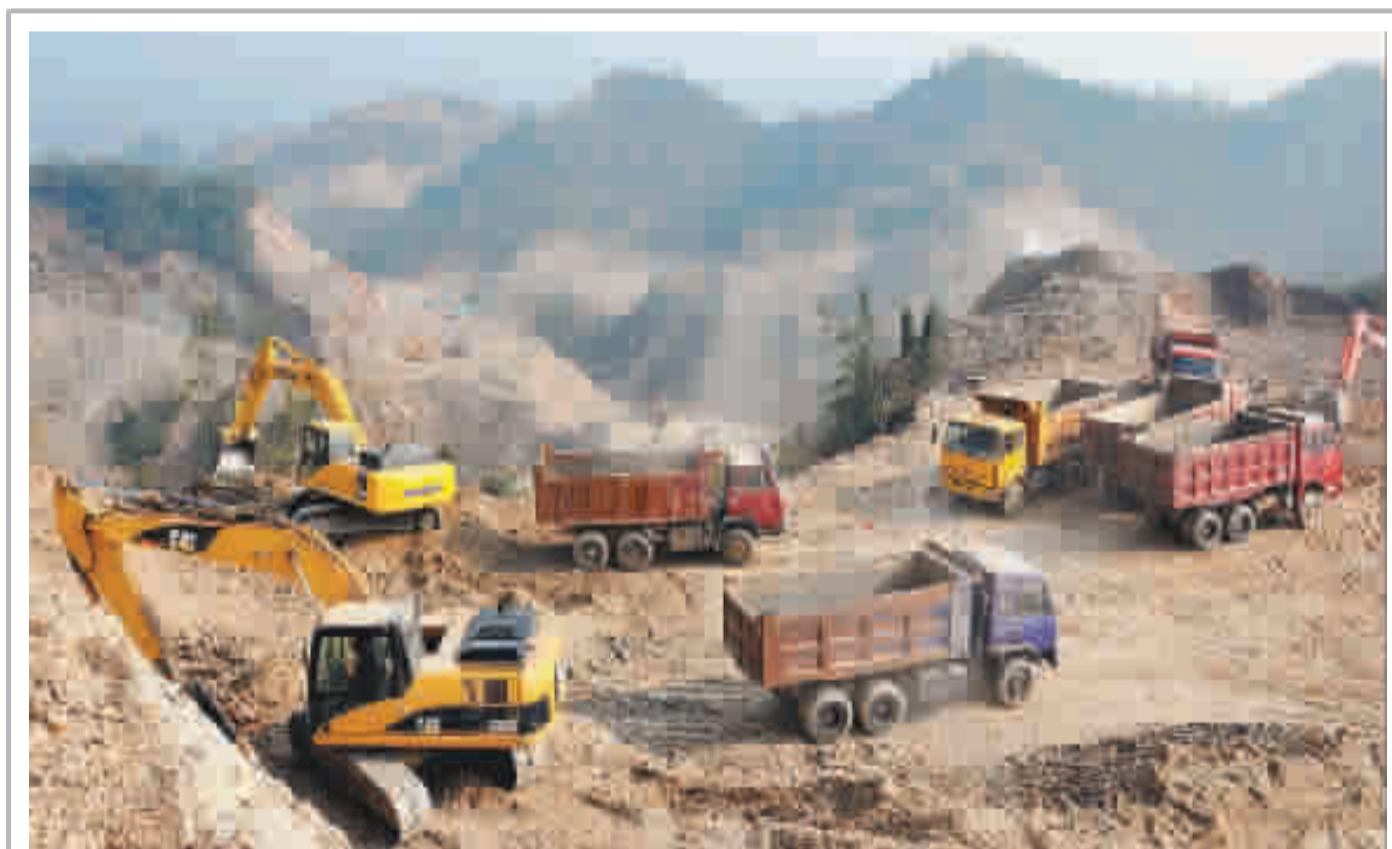
12月23日,在东风商用车8万辆新基地山上片区建设工地上,100多台大型施工机械、300余台重型车辆、2000余名建设者正全力整理山地。目前,东风商用车8万辆新基地山上片区工程已开挖土石方570余万方米,占总工程量的30%,连接山上、山下片区的跨河桥梁工程已于11月15日开工建设。记者刘旻 特约记者马晓璐 通讯员杨林松摄
