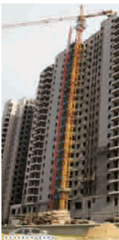
老寨沟安置区项目建设现场
