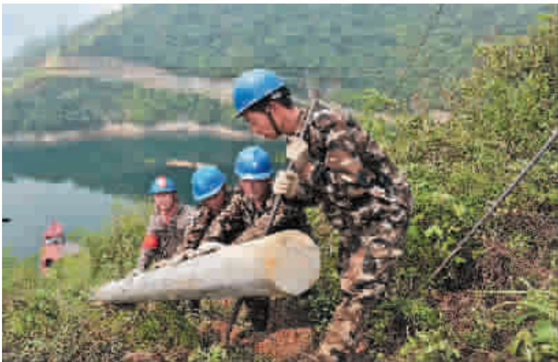
人工运送2吨重的水泥电线杆
