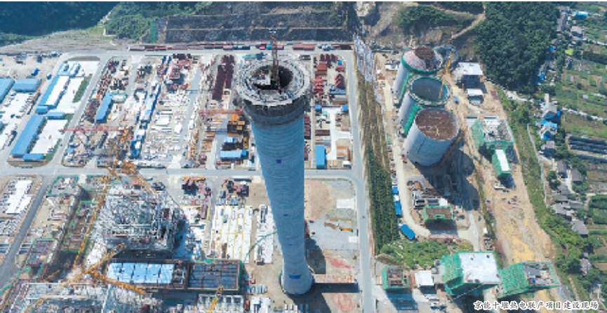
京能十堰热电有限公司项目建设现场
