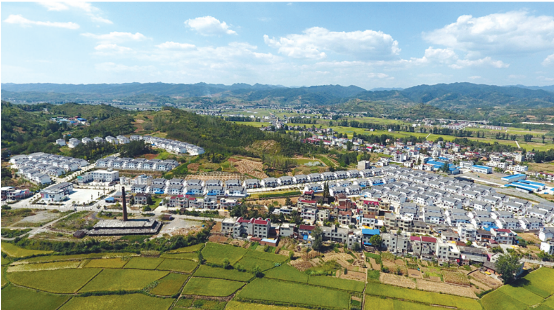
易地扶贫搬迁安置点
