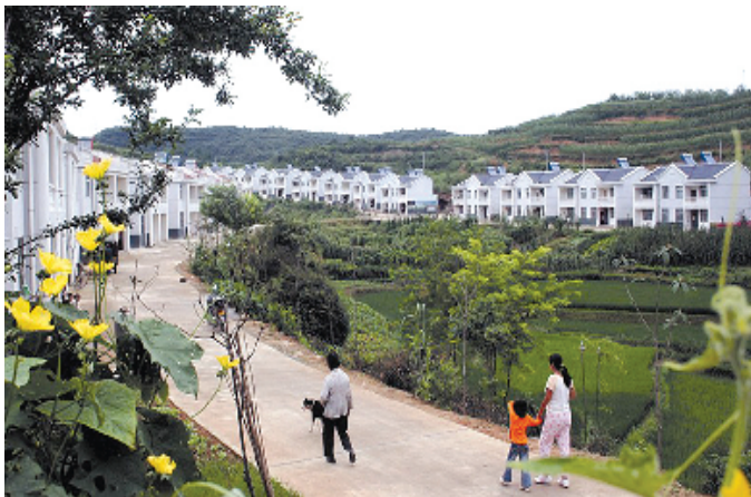
房县园艺场古桥沟村安居工程
