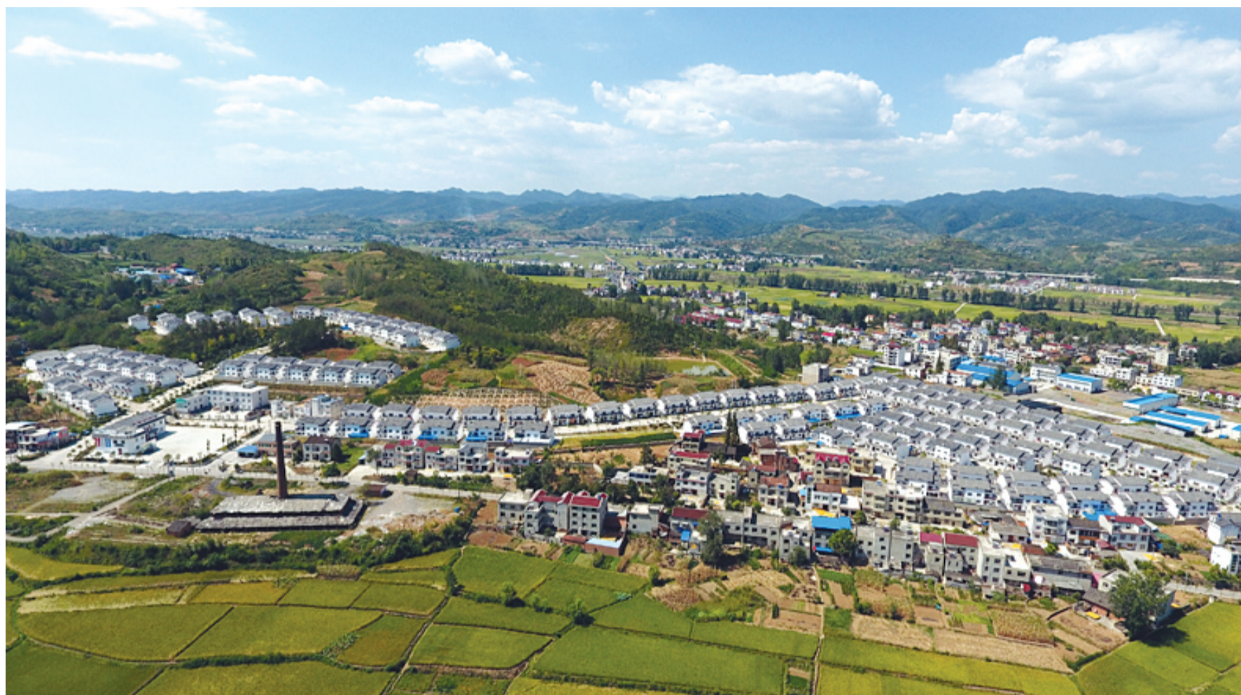
易地扶贫搬迁安置点
