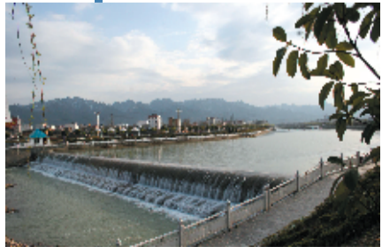
房县西河防洪工程
