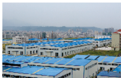
拔地而起的现代化厂区
