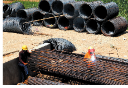
白鹤镇伏溪村滑坡体治理现场
