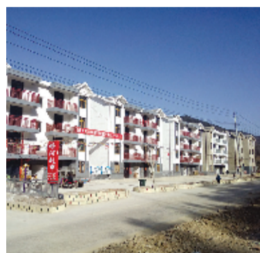
堰河村上楼安置小区
