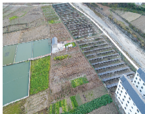
下坝村光伏发电基地
