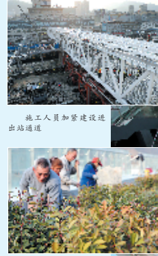
施工人员进行配套设施建设
