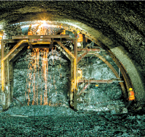
2月9日,竹山县潘口乡鱼岭一号隧道内,工人正在加紧施工,掘进隧道,切割钢板,现场一派忙碌的建设景象。
