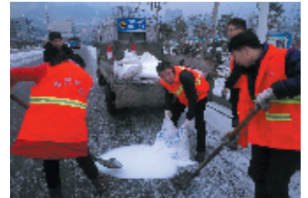
2月10日上午,市政工程管理处在通往十堰火车站北广场的马路撒盐除冰,保障道路畅通。记者张治国摄
