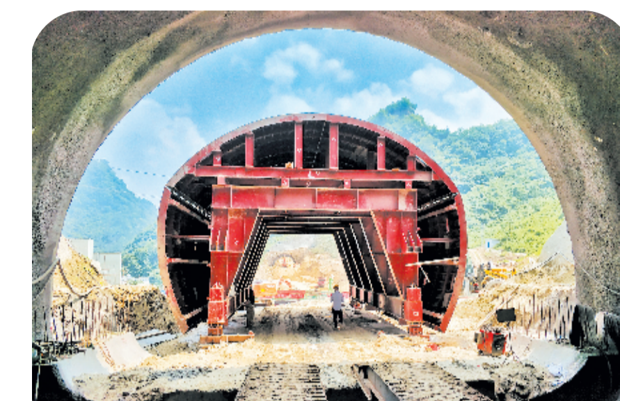
十堰高速鸡公寨隧道建设现场
