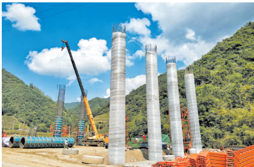
十堰高速拉鱼河7号桥建设现场
