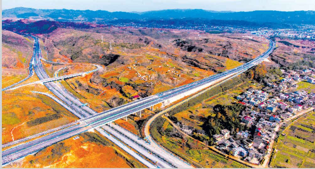
谷村—十房高速房县枢纽互通
