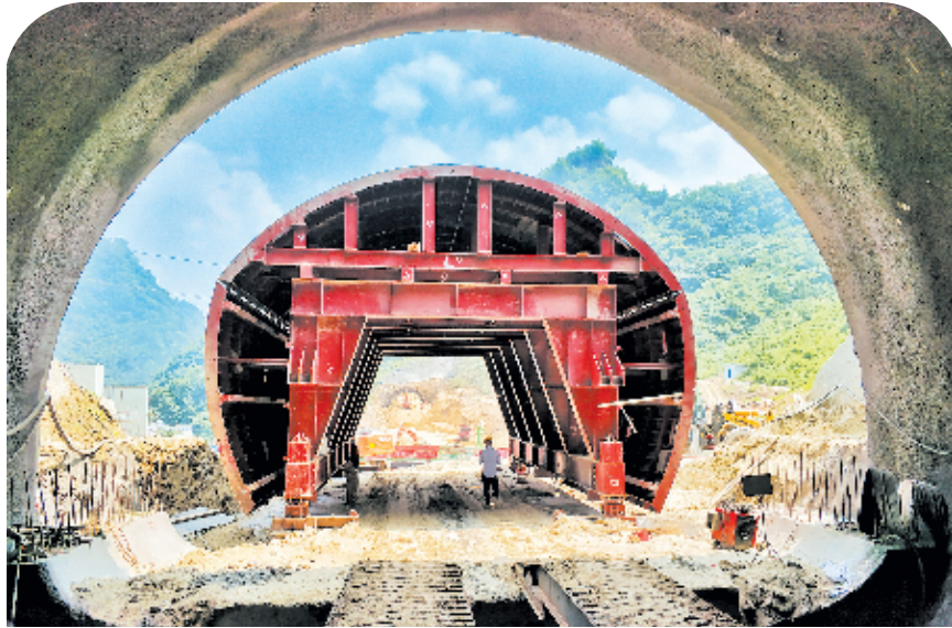
十堰高速鸡公墓隧道建设现场
