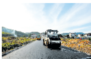
路面铺设现场
