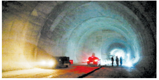
管廊隧道(建设期拍摄)
