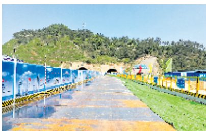
十堰城区林荫大道管廊隧道(建设期拍摄)
