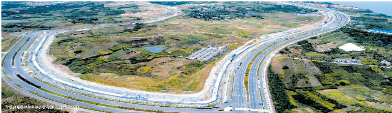
十堰生态滨江新区综合管廊项目(建设期拍摄)
