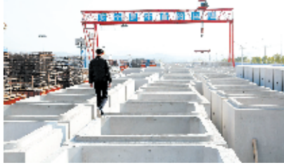
管廊预制构件(建设期拍摄)
