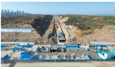
十堰生态滨江新区管廊项目(建设期拍摄)
