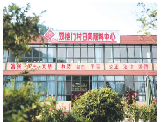
日间照料中心
