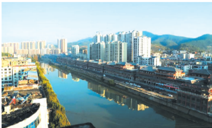
西关街改造融江南水乡特色与明清建筑风格于一体
