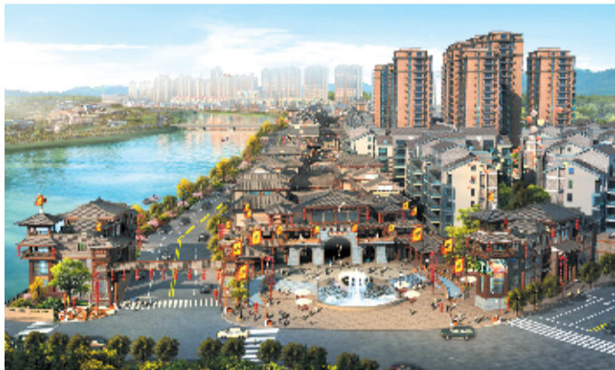
改造后的西关街是竹溪标志性新城区
