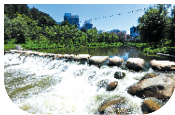
神农河示范段新建跌水堰成为景观第一方阵。
