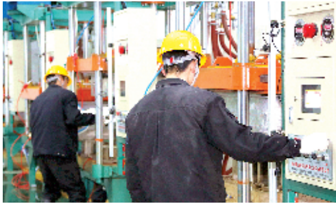
昨日,在十堰市江苏商会捐助的鄂西天河英才实验学校,工人们正在检查设备安装。该项目位于茅箭区茅箭镇,总投资 1.5 亿元。项目引进先进生产设备,实现生产环境绿色环保。预计 2019 年可实现产值 4 亿元,纳税 2500 万元。 记者李正 摄
