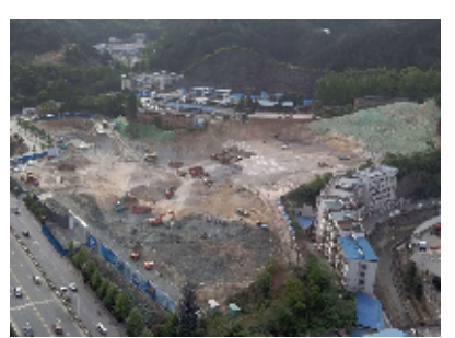
“五一”期间，中国一冶十堰市常隆花园项目施工人员奋战在施工现场。截至目前，该项目基础第一层土石方已开挖完成，即将进行第一层基础浇筑施工和第一层基础开挖。据了解，十堰市常隆花园项目是我市重点民生工程，一期工程概算总投资4亿元，占地面积31887平方米，包括5栋高层住宅楼、1所幼儿园、1栋配套用房，总建筑面积169023平方米，其中地下131242.25平方米，地下3778.28平方米。两层地下室开挖最大深度为9米，为保证安置户尽早入住，施工人员和建设单位投入70余台机械设备，100余名工人加班加点推进工程进度。 通讯员蔡志刚 摄
