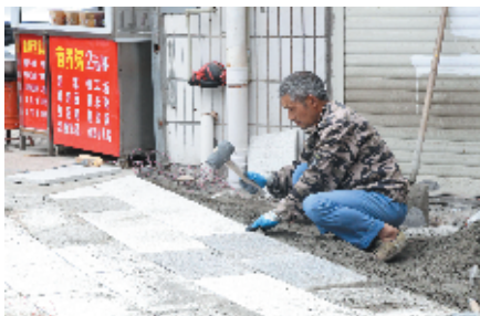
背街小巷改造施工现场
