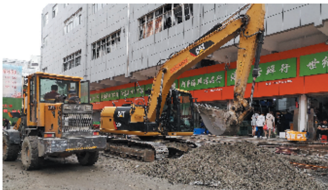
老虎沟农贸市场改造施工现场
