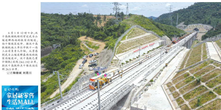
6月11日12时9分,汉十高铁顺利穿过武当山隧道群西端的铁家沟隧道,向十堰城延伸。据汉十高铁建设指挥部介绍,汉十高铁已贯通全线,距汉十高铁终点十堰北站仅剩24.5公里。
