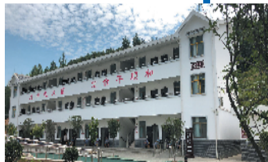
郧阳区杨溪铺镇中心李福院项目
