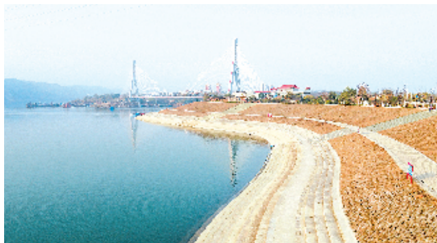
支持汉江堤防加固工程项目建设2亿元
