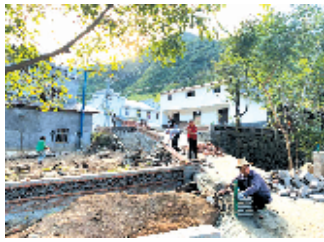
连日来,竹山县双台乡关沟村组织村民修缮房屋前后后墙和围墙。在实施“5+1”行动中,该县坚持“实地检验、群众评议、因地制宜”原则,落实落细乡村振兴举措,切实提升群众幸福感和获得感。
