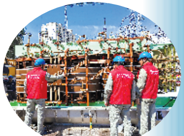
随州变电站变压器吊芯施工现场
