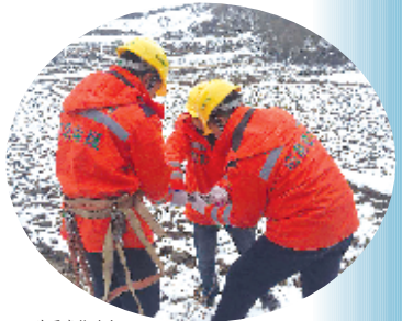
铁甲检修进度
