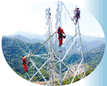
电力工人深山组塔施工
