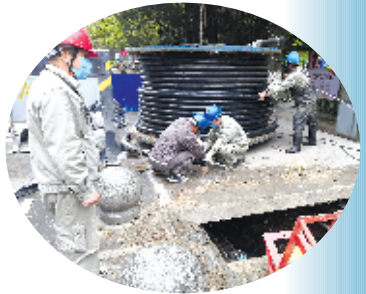
“三供一业”施工现场
