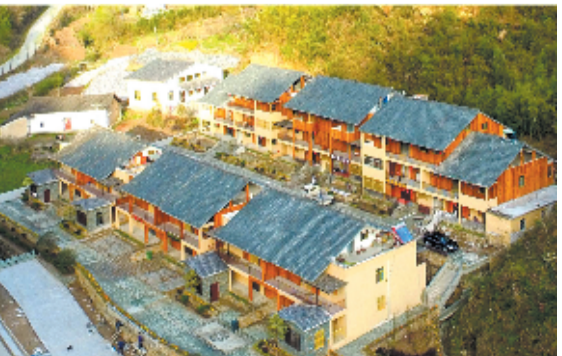
大川镇浪溪村邓家院易地扶贫搬迁安置点
