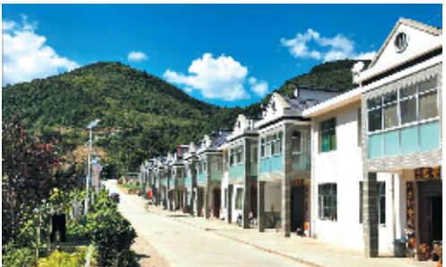
支持易地扶贫搬迁房屋建设
