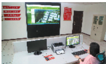
監測員通過智慧糧庫集成管理系統對倉房溫度、濕度、蟲害等情況進行實時監測。
