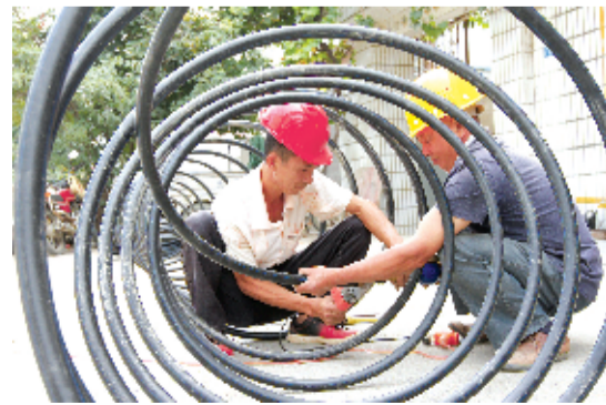
安全饮水工程施工
