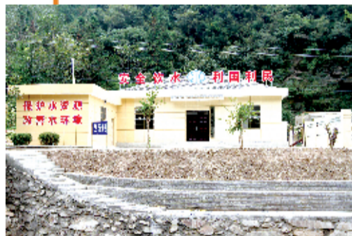
新建的土城花楼水厂
