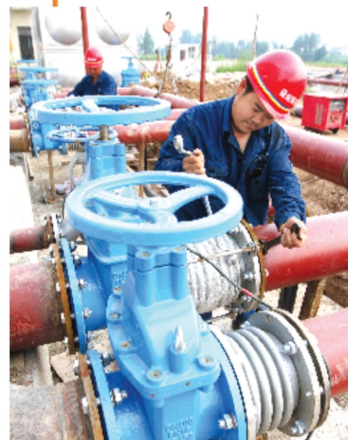
安装供水管道
