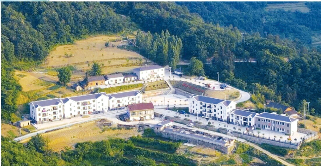
沙河乡朱家坪村易迁安置小区
