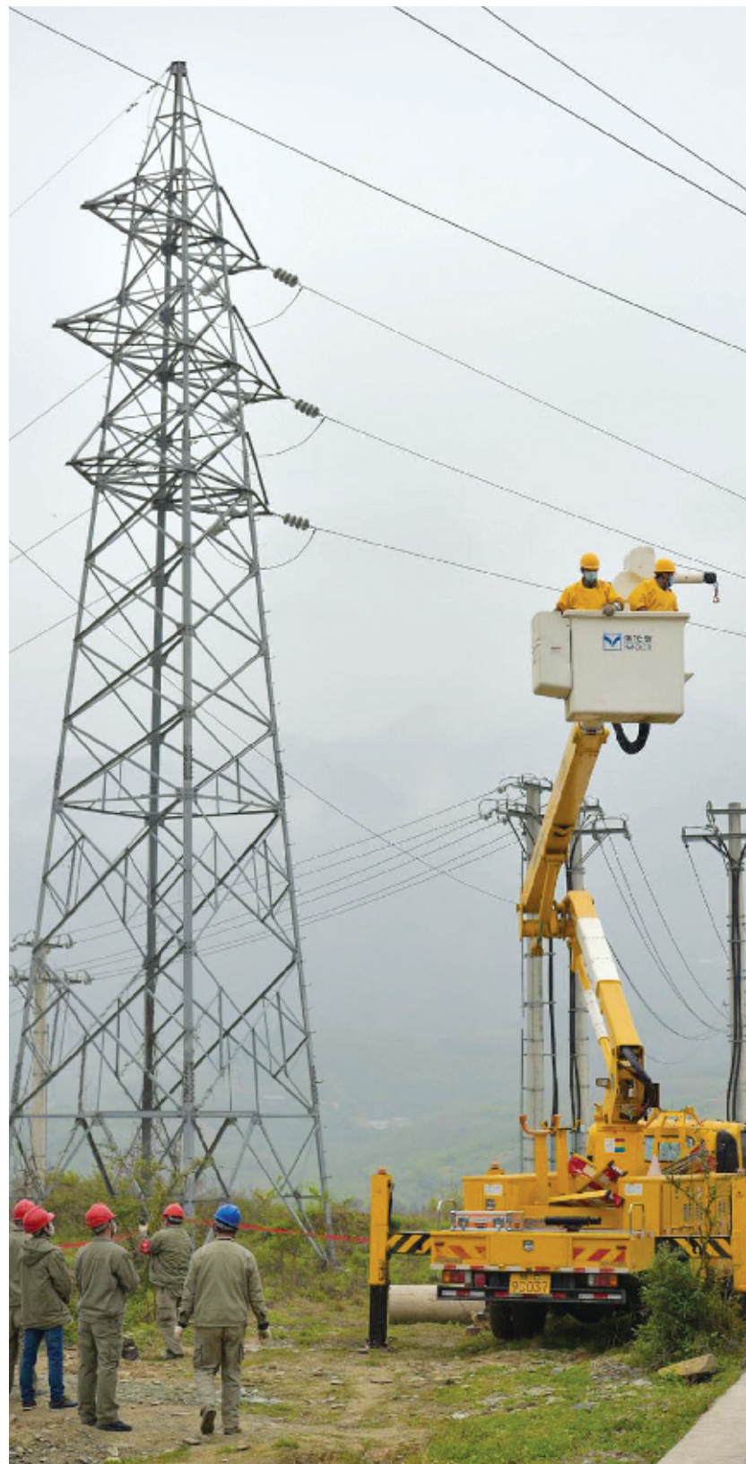
电力工人高空作业
