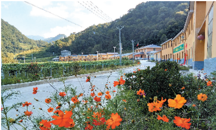
泉溪镇坝河村易地扶贫搬迁安置点
