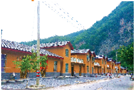
泉溪镇易地扶贫搬迁安置点
