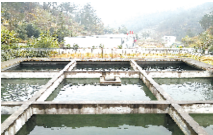
城关镇大裕沟村安全饮水工程
