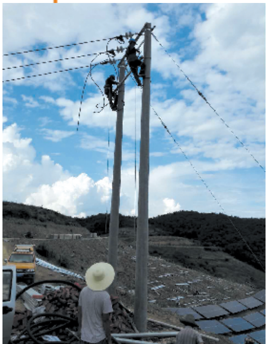
架设光伏电线
