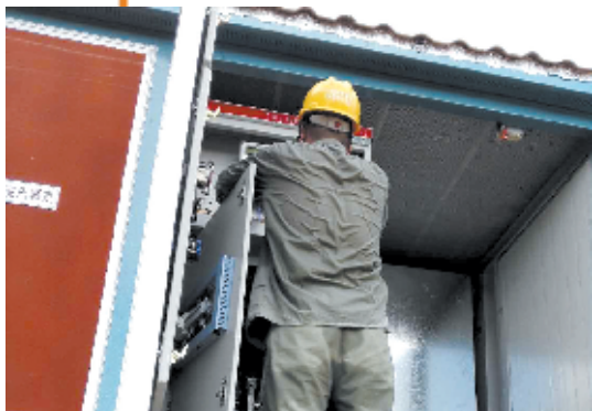
维修光伏电箱
