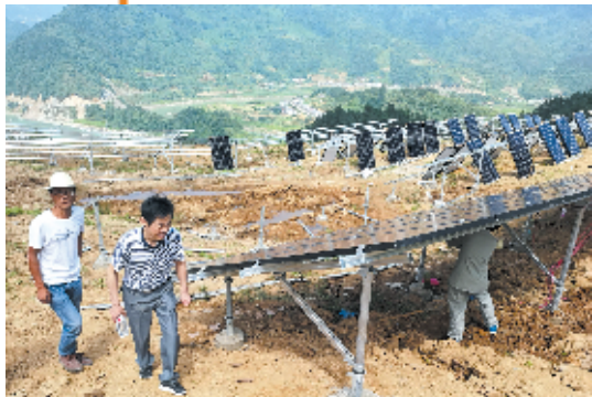
维护光伏电板
