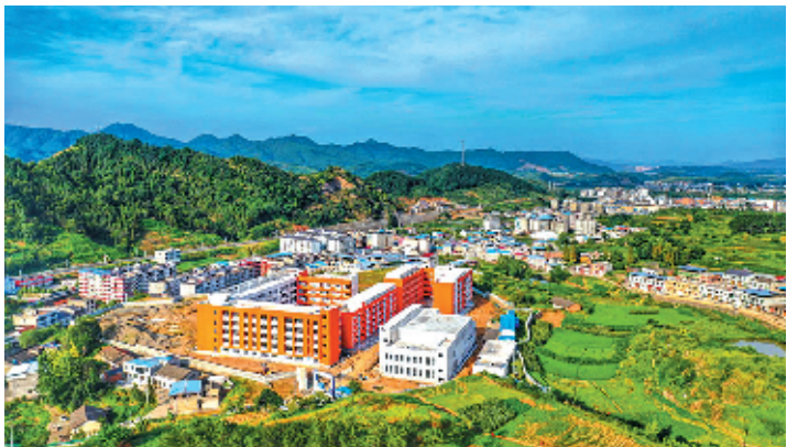
蒋家堰新中学建设
