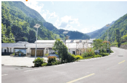
通村公路硬化
