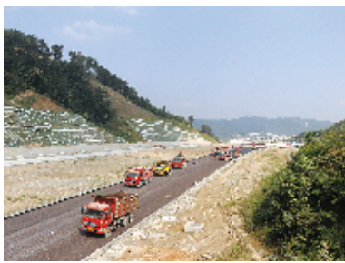
加快推进十堰生态廊道丹江口至武当山一级公路建设
