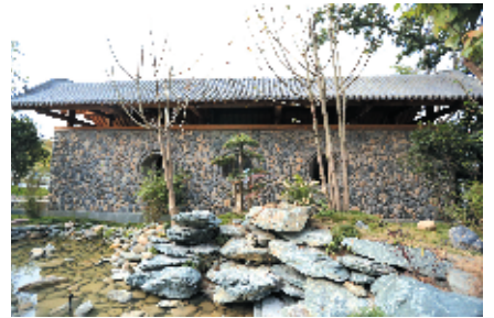
一期建设已经基本完成,本月底将正式运营
