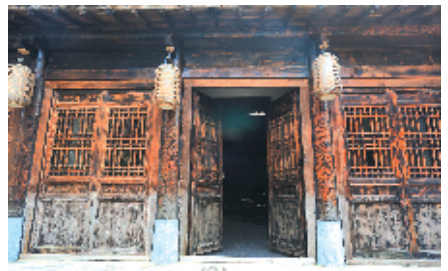
民宿主体改造采用传统木结构、抬梁式结构
