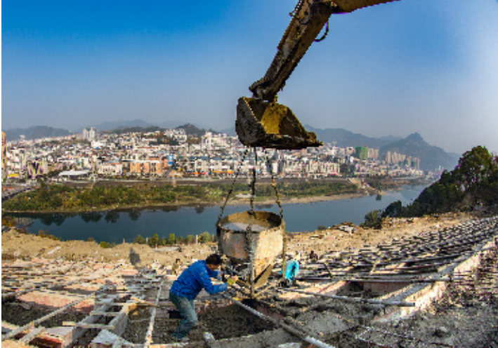
除隐患保畅通 11月14日，在竹山县城关镇内村公路建设上，工人正在治理公路滑坡。近年来，竹山县多措并举清除道路桥梁险情，确保道路安全畅通。
