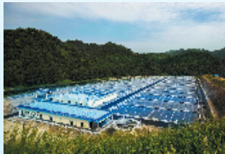
泗河污水处理厂人工快渗工程
