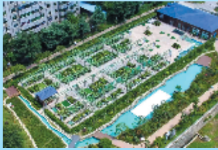
车站沟花园式污水处理微站
