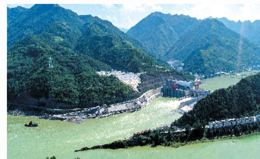
汉江夹河关水电站
