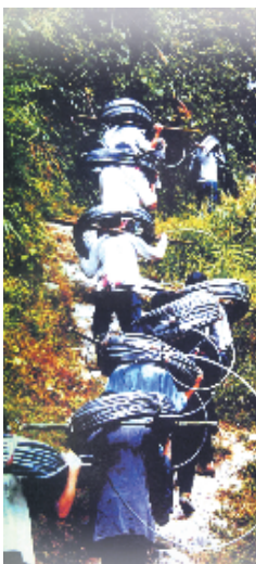
电力员工扛电杆进深山(资料图片)
