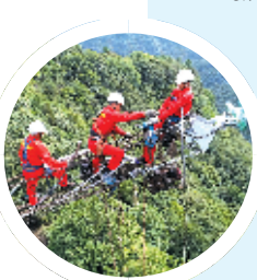
电力员工在500千伏十陵一卧龙输电线路开展线路投运前的隐患排查(资料图片)
