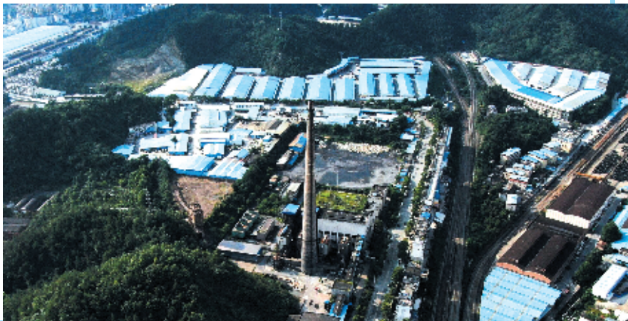
市热电厂全景图 记者刘昆 摄
