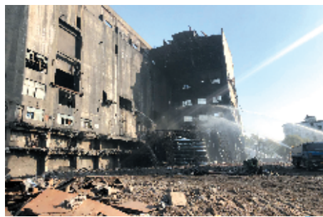
拆除施工现场 记者王雁博 摄
