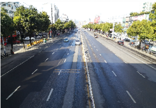
干净宽敞的道路
