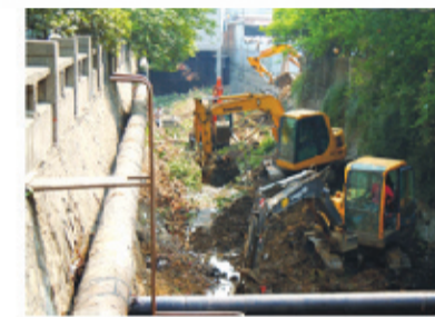
郧河流域方山河道清淤现场
