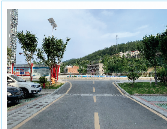
十堰经济技术开发区白浪街办光明社区路口改造前
